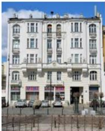
Budynki sprzed 1945 roku
